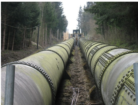
Genietete Druckrohrleitung
