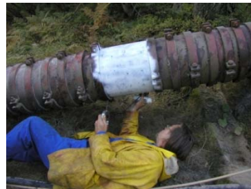
Druckrohrleitung Außeninspektion
