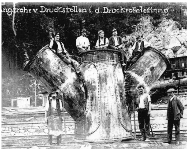
Abzweigstück einer Druckrohrleitung aus 1928
