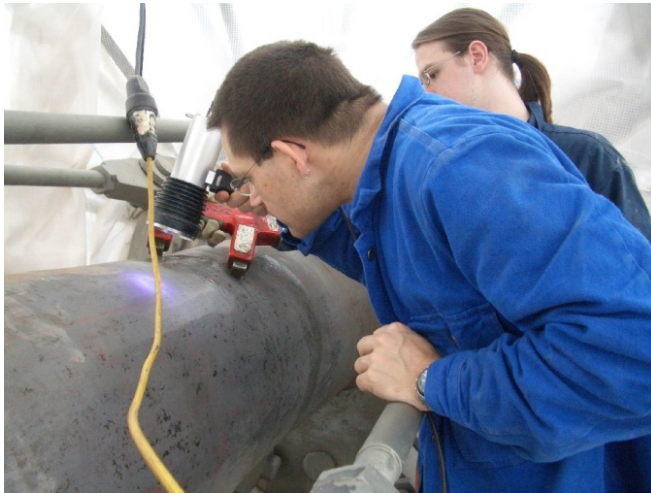
Prüfung der Welle des Wiener Riesenrades
