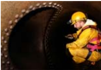
Genietete Druckrohrleitung, Inneninspektion
