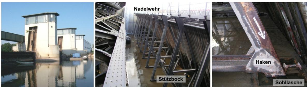
Abbildung 1: Aufbau Revisionsverschluss
